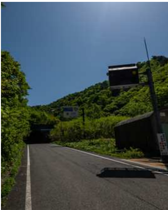
77.3km付近の隧道入口
