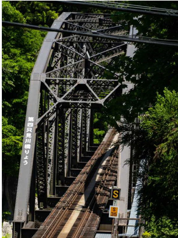
第4只見川橋梁
