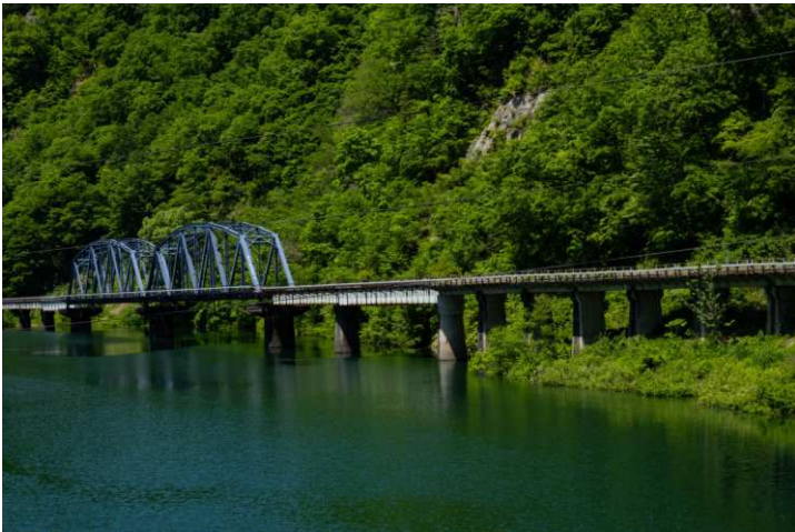
第8只見川橋梁
