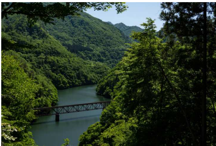
第3只見川橋梁
