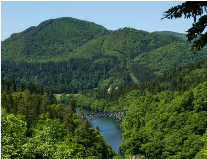
第1只見川橋梁
