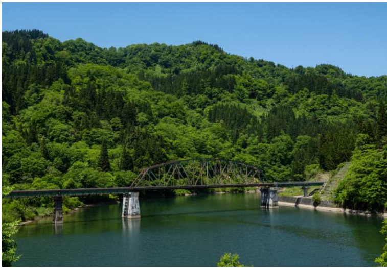
第6只見川橋梁(別ショット)
