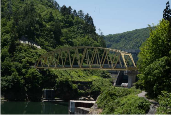
第6只見川橋梁(125.8km 付近)
